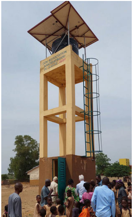
L’une des réalisations de l’association à Ourboug, une adduction d’eau avec un château d’eau, pompe et panneaux solaires en 2021.
