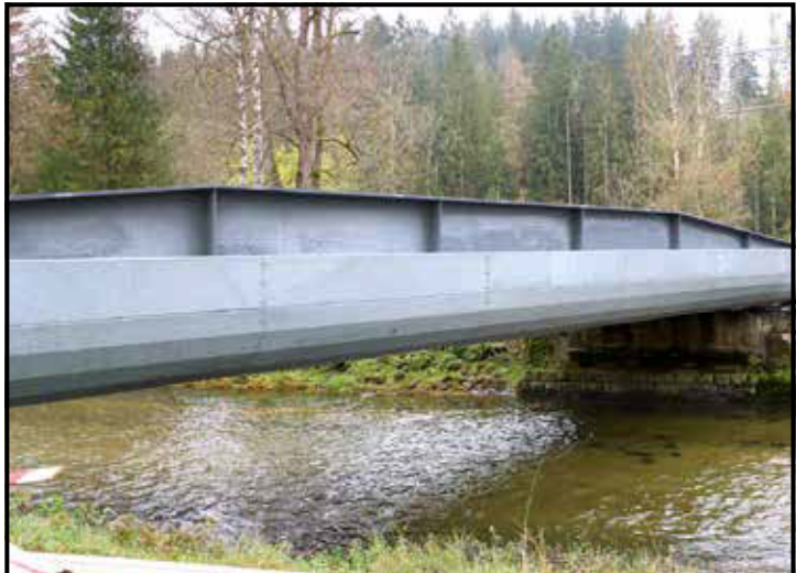
Cette coque arrondie doit protéger la structure en cas de crue.
