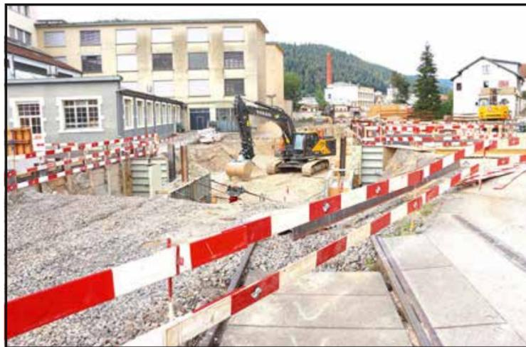
Les travaux de la gare de Couvet visent à offrir aux clients de la ligne ferroviaire du Val-de-Travers une infrastructure d'accueil et d'embarquement moderne et adaptée aux besoins actuels et futurs : allongement et rehaussement des quais, renouvellement complet des voies et de la ligne de contact, passage inférieur pour piétons, marquise et salle d'attente. Fin des travaux prévue à la mi-2025.
