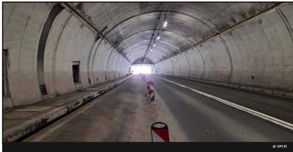
Après un peu plus de deux ans de travaux, la galerie de sécurité du tunnel de la Clusette est excavée et le revêtement intérieur bétonné. L'installation des équipements électromécaniques et de sécurité est en cours, ce qui permettra d'ouvrir la galerie au mois d'octobre prochain.
