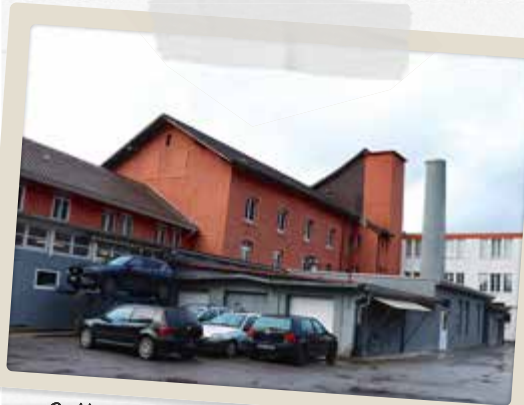
Cette protubérance cache en réalité le monte-charge installé par l'ancienne fabrique de meubles Bachmann.
