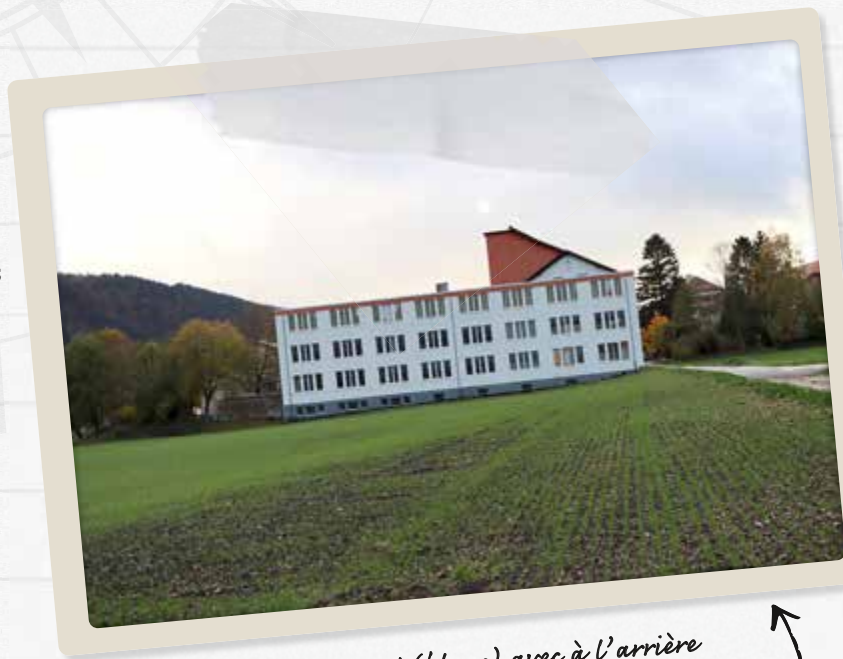
Le bâtiment Est (blanc) avec à l'arrière la protubérance couleur brique.
