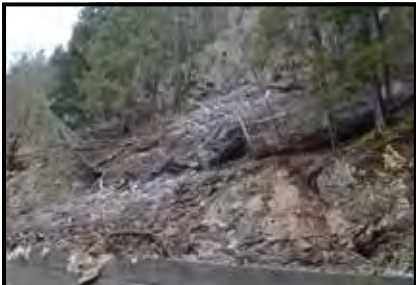
Face à la puissance de l'éboulement, les barrières de protection n'ont tout simplement pas tenu la comparaison.
