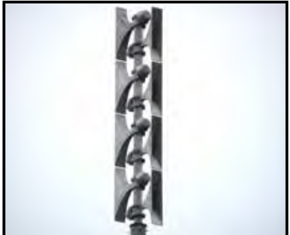
En fonction de la taille du village à couvrir, les sirènes ont plus ou moins de sorties. Celle de Couvet en a huit pour une puissance de 1000 watts.
