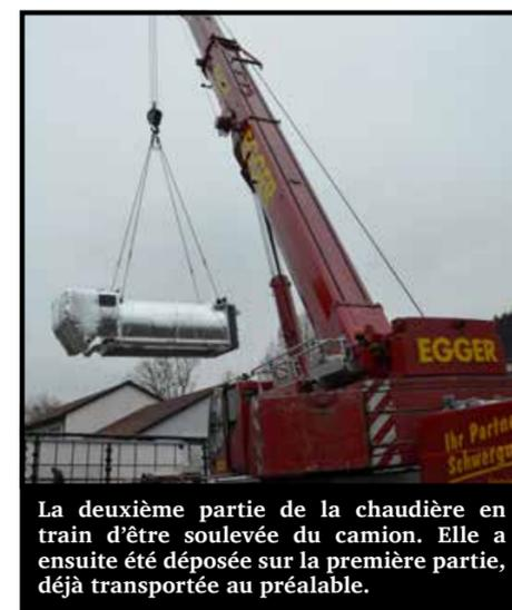
La deuxième partie de la chaudière en train d'être soulevée du camion. Elle a ensuite été déposée sur la première partie, déjà transportée au préalable.
