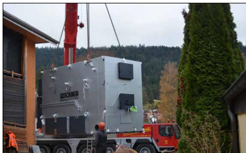
La grue de levage dépose la première partie de la chaudière délicatement. Un beau bébé de 23 tonnes !
