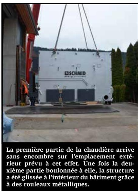
La première partie de la chaudière arrive sans encombre sur l'emplacement extérieur prévu à cet effet. Une fois la deuxième partie boulonnée à elle, la structure a été glissée à l'intérieur du bâtiment grâce à des rouleaux métalliques.
